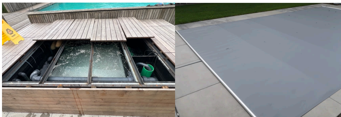
Abbildung 2: Referenzanlage - Biofilter in der Biobadi Biberstein und Poolabdeckung zur Filtersicherung.
