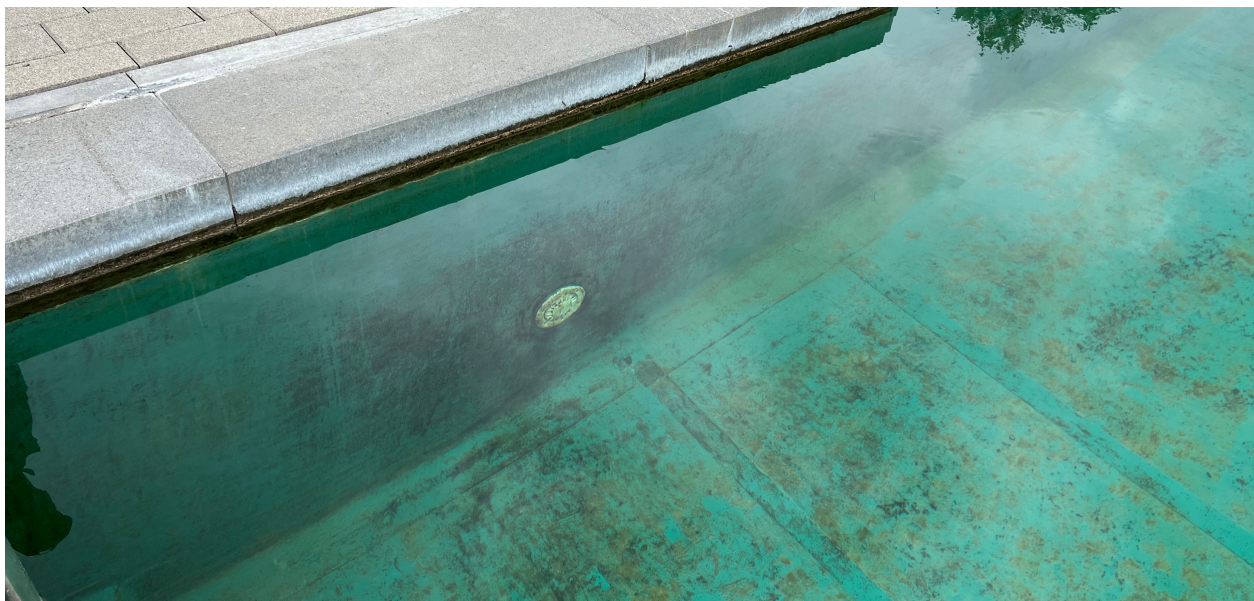
Abbildung 3: seitlich, sternförmig ausströmende Düse, mit angrenzender, verstärkter Belagsbildung
